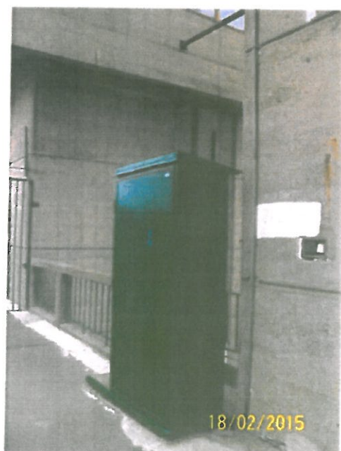
Hlavní rozvaděč jezu na jezové lávce u levého pípfře.
