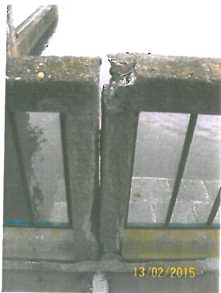
Degradace betonů - zábradlí
